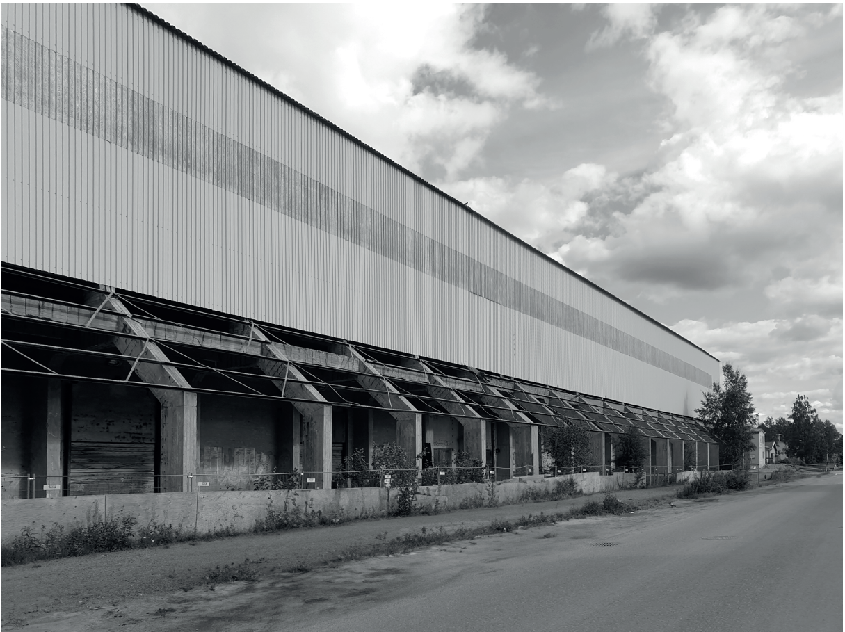
Varastorakennus ennen purkua.
